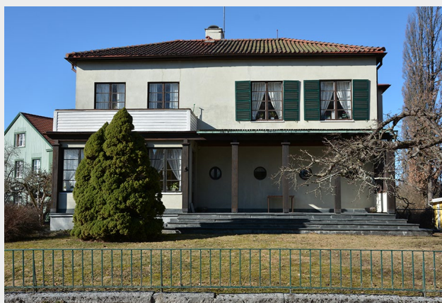
■ Bostadshus från 1931 ritat av arkitekt Viktor Norberg i tjugotalsklassicistisk stil. Byggnaden i två våningar har en arkad med brunmålade kolonner och trappa i skiffer. Fönsterbågar är brunmålade och jalousier grönmålade (Petra 7). Foto: Vlm-vassb-0146.
