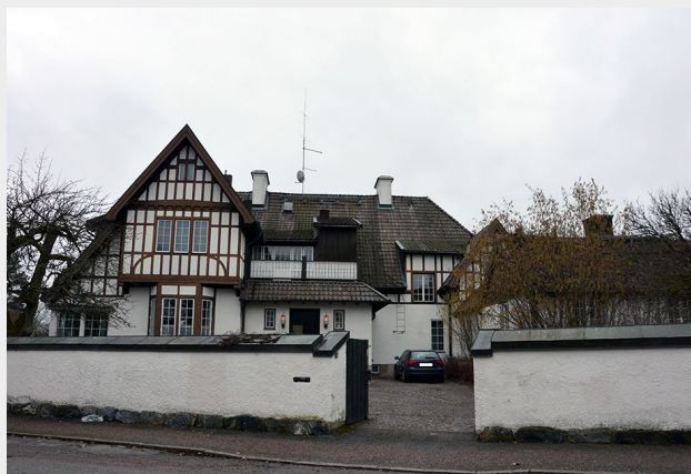
■ Falkbo från 1905. Uppförd i engelsk nationalromantisk stil med korsvirkesteknik i två våningar, oregelbunden planlösning och brant tak med ett ovanligt tegel (Paulina 6). Foto: Vlm-vassb-0372.
