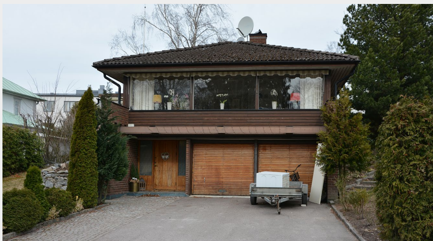
■ En av två identiska villor som ligger bredvid varandra och uppfördes 1973. Bostadshusen är utförda i material och stil typiskt för 1970-talet. De har fasader av brunt fasadtegel och brunmålad träpanel, perspektivfönster mot gatan, dörrar i trä och valmat tak täckt av betongtegel (Palla 10). Foto: Vlm-vassb-0479.
