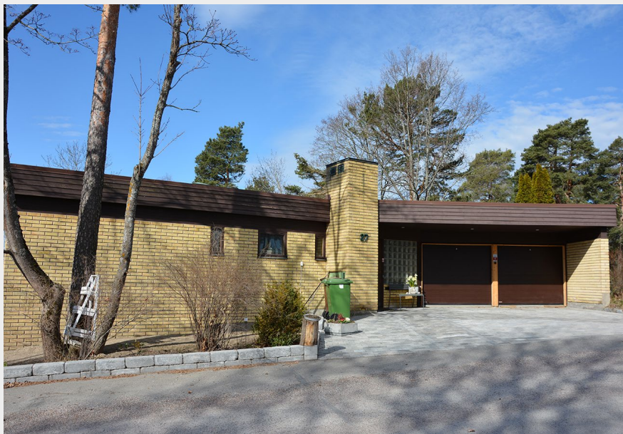
■ Bostadshus uppfört 1966 med en sluten och låg byggnadskropp lätt vinklad utmed gatan. Fasad i gult tegel och ett platt tak med sarg i brunmålad träpanel. (Bredablick 3). Foto: Vlm-vassb-0776.
