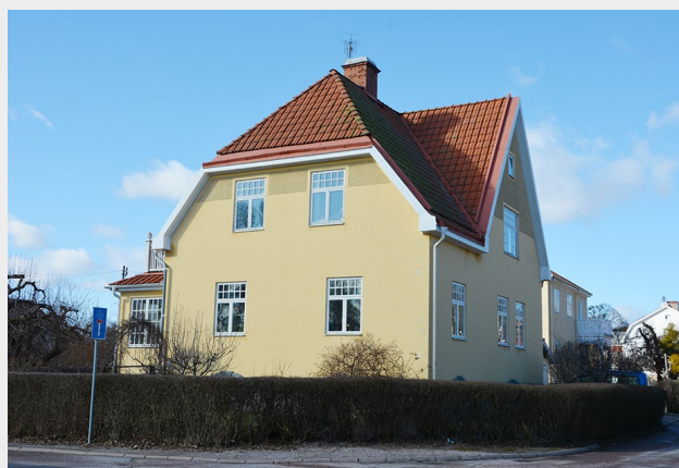
■ Bostadshus från 1913 i en och en halv våning. Hade ursprungligen två lägenheter. Den gula putsen är slät förutom på gavelrösten där den är grov. Jugendfönster med tvärpost och småspröjsad överdel. Delvis valmat sadeltak med lertegel (Annedal 4). Foto: Vlm-vassb-0265.
