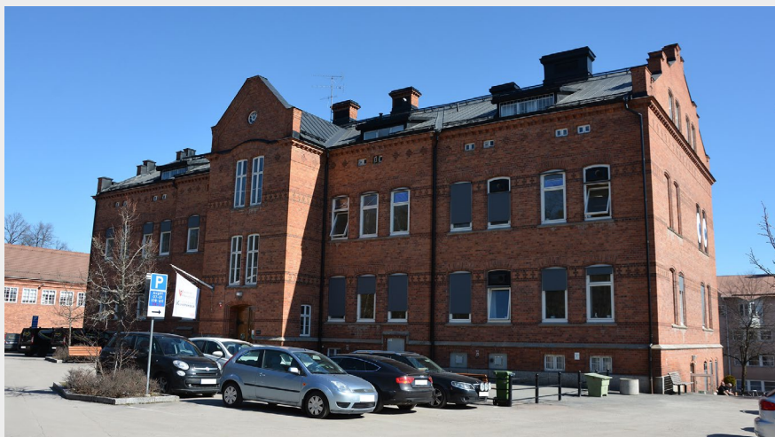
■ Djäknebergsskolans huvudbyggnad i rött tegel, markerat trapphus, regelbunden fönstersättning och tak täckt av plåt (Idun 3). Foto: Vlm-vassb-0934.
