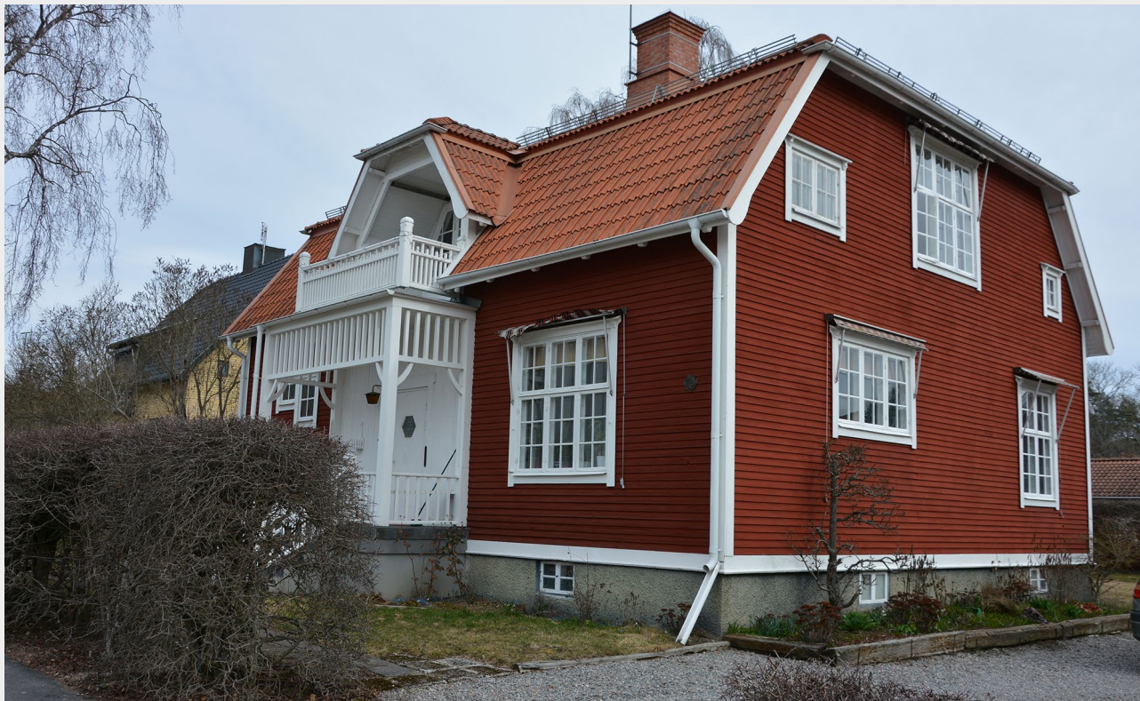
■ Nationalromantisk villa från 1910. Fasaderna klädda med rödslammad, liggande träpanel och vitmålade snickerier. Fönsterna är småspröjsade med asymmetrisk placering. Ingångsparti har veranda och balkong (Hagdal 7). Foto: Vlm-vassb-0491.
