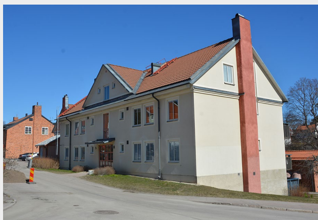
■ Bostadshus från 1993 i lekfull postmodern stil med anpassning till närliggande industribyggnad gällande volym, kulör och detaljer (Norra Kvarnvreten 6). Foto: Vlm-vasek-3521.
