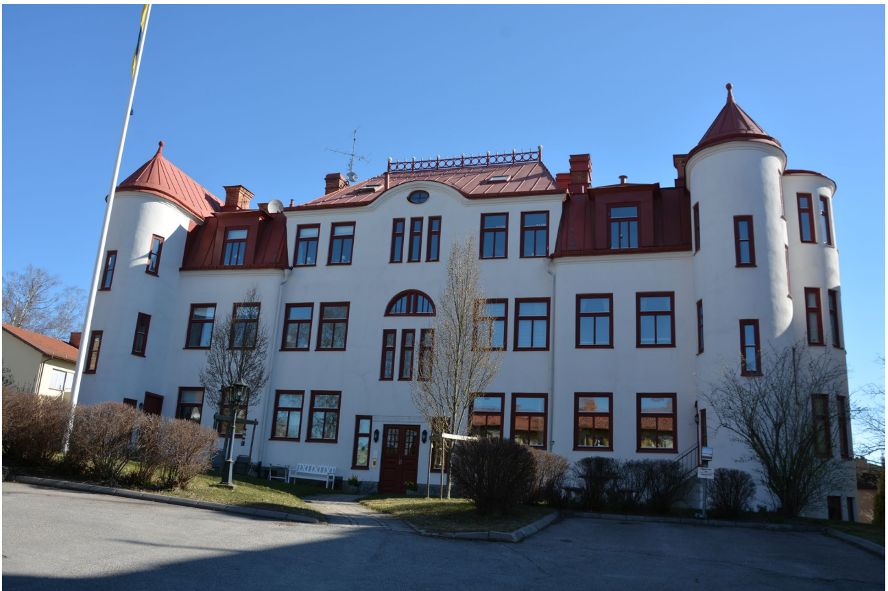
■ Bostadshus i stadsdelen Jakobsberg. Den vitputsade byggnaden med slottskaraktär har ett centralt placerad entréparti där trapphuset har ett stort välvat fönster. Byggnaden har hörntorn och ett rött plåttak med takkupor. Foto: Vlm-vassb-0979.
