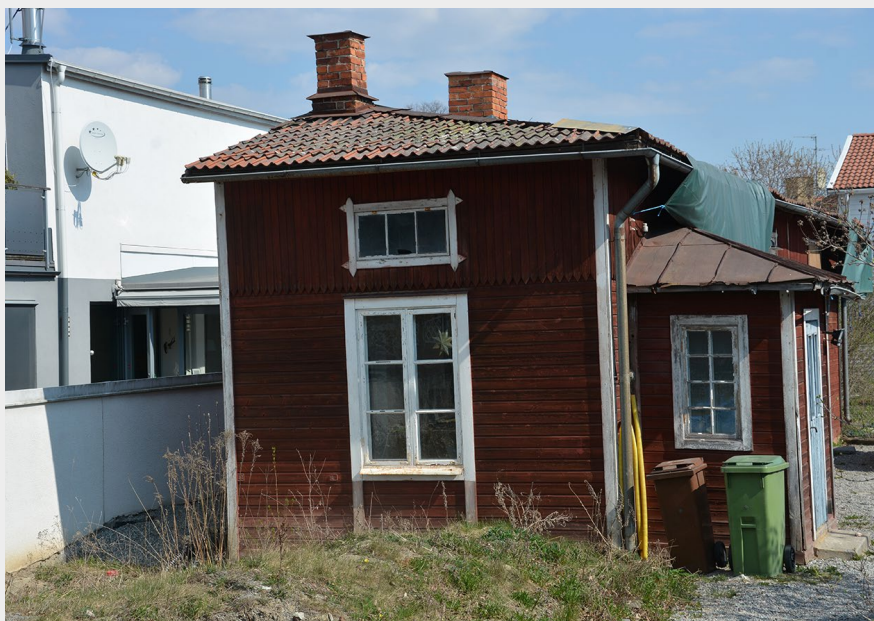
■ Uthus med faluröd stående och liggande fasspontpanel och vitmålade snickerier (Gnejsen 10). Foto: Vlm-vasek-3848.
