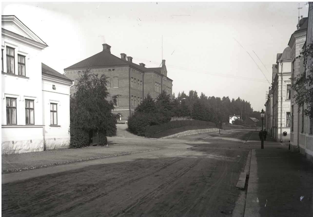
■ Djäknebergsskolan vid 1900-talets början, sedd från söder vid nuvarande Västra Ringvägen. Notera att byggnaden saknar de senare tillkomna trappstegsgavlarna. Foto: Ernst Blom.
