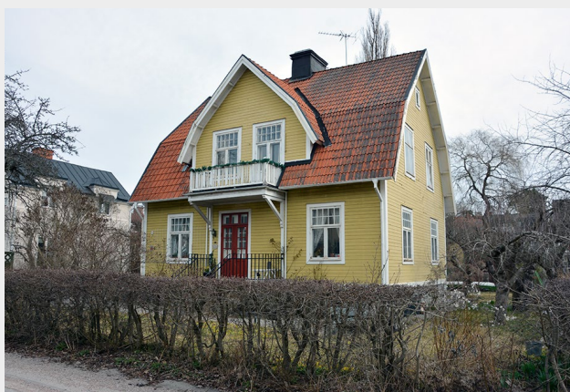
■ Villa från 1912 byggd i en och en halv våning med liggande gulmålad träpanel. Jugendfönster med tvärpost och småspröjsad överdel. Brutet tak täckt med lertegel. Ingångsparti med balkong och frontespis (Marianne 8). Foto: Vlm-vassb-0489.
