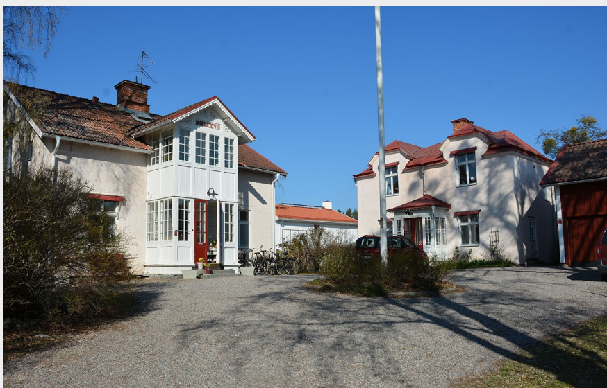
■ Bebyggelsemiljö från sekelskiftet 1900 med två bostadshus och ett bevarat uthus kring en grusad yta. Bostadshusen har fasader av ljus spritputs och glasverandor, uthuset är klätt med faluröd träpanel (Fältspaten 6). Foto: Vlm-vasek-3783.
