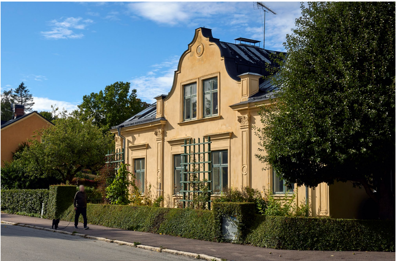
■ Gulputsat bostadshus i klassisk arkitektur med fasaddekor i form av pelare och fönsteromfattningar. Centralt placerad frontespis med ett böljande bandtäcktt plåttak. Huset har grönmålade spröjsade fönster. Foto: Lasse Fredriksson.
