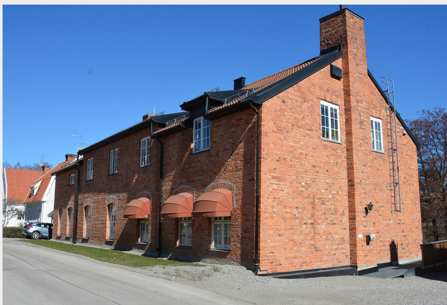
■ Före detta fabrik/snickeri i rött handslaget tegel, småspröjsade vitmålade träfönster, skorsten från gavel och tegeltäckt sadeltak (Norra Kvarnvreten 5). Foto: Vlm-vasek-3530.
