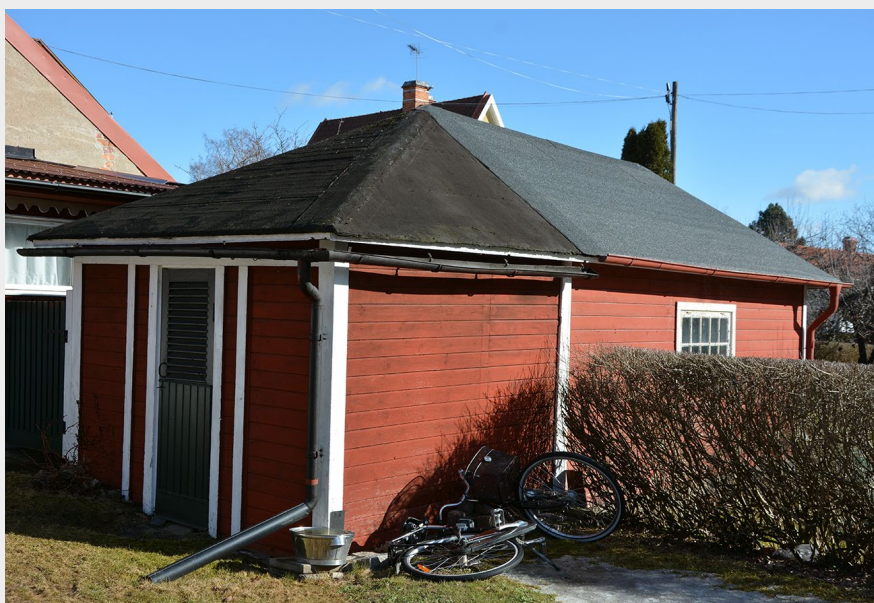
■ Dass från 1910-tal, ett av de ursprungliga gårdshusen som hörde till bostadshusen. Liggande rödmålad träpanel, vita snickerier och grönmålade fönster och dörrar. Valmat sadeltak med svartmålad papp (Annedal 5). Foto: Vlm-vassb-0273.
