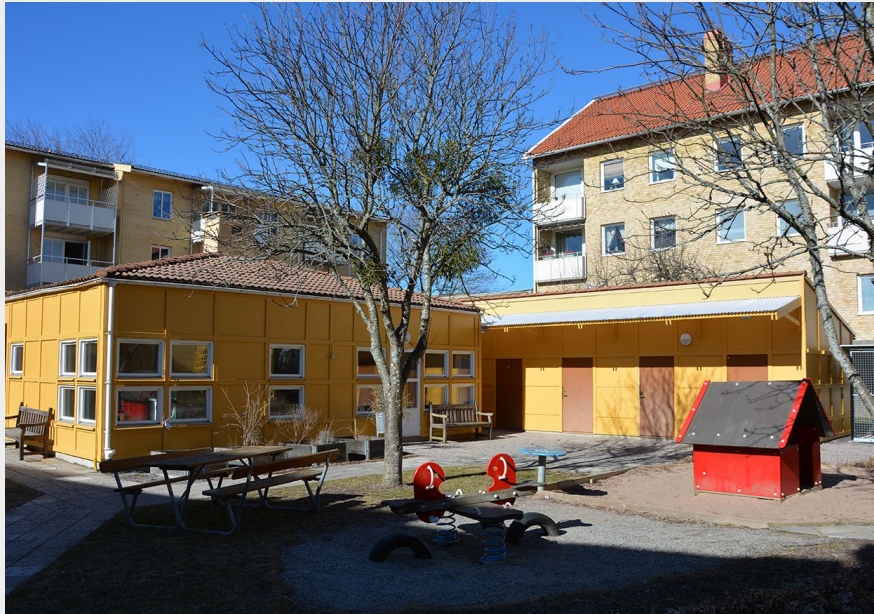
■ Förrådsbyggnad från 1985 med gul fasadplåt. Byggnaden är placerad på innergården vid husen mot Hammarbygatan (Sandstenen 17). Foto: Vlm-vassb-0447.
