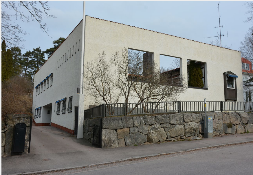
■ Bostadshus uppfört 1950 med rätlinjig och sluten fasad med vit spritputs, små fönsteröppningar och en sluten innergård. (Bredablick 11). Foto: Vlm-vassb-0610.
