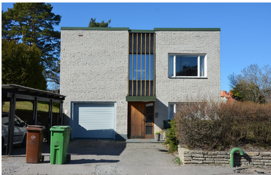
■ Bostadshus med strikta fasader av vit mexisten, rätvinklig byggnadskropp och plant tak (Klippan 25). Foto: Vlm-vassb-1008.
