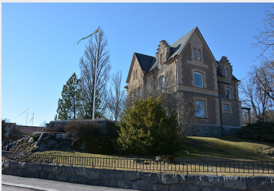
■ Cronstrandska villan från 1887. Högt belägen på en stor kuperad tomt. Uppförd i eklektisk stil med influenser från engelsk gotik. Ljust putsad fasad i en grov puts med runda kiselstenar. Slätputsade hörnkedjor och fönsteromfattningar (Neta 6). Foto: Vlm-vassb-0161.
