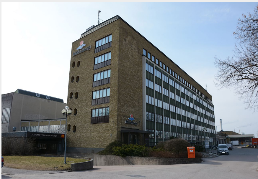
■ Hakonhusets huvudkontor uppfört 1957 i gult fasadtegel med horisontella fönsterband (Gustavsvik 13). Foto: Vlm-vassb-0537.
