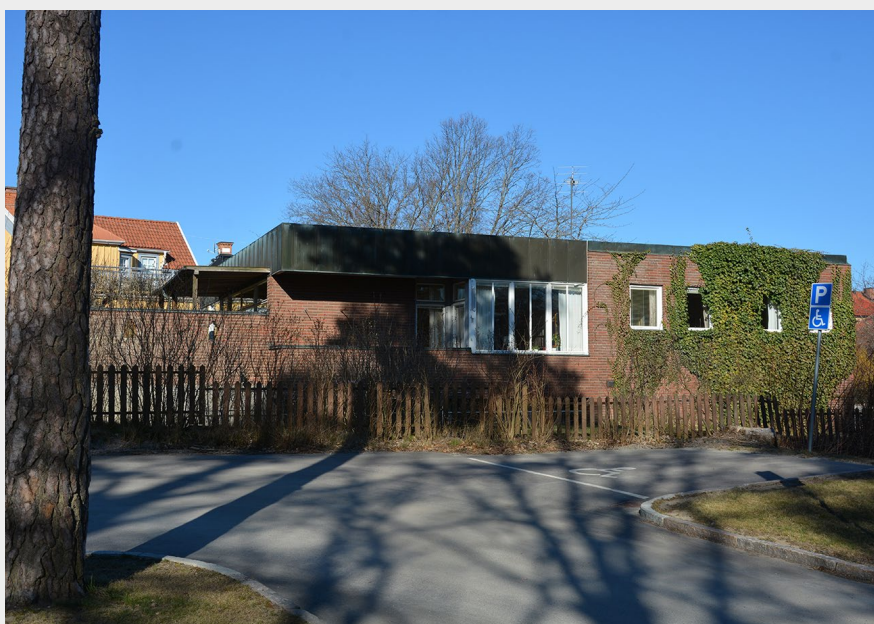
■ Bostadshus från 1963 uppfört i rödbrunt tegel med vitmålade fönsterpartier och partier av kopparplåt. Ritad av arkitekt Nils-Olof Tollbom (Krutet 8). Foto: Vlm-vasek-3695.
