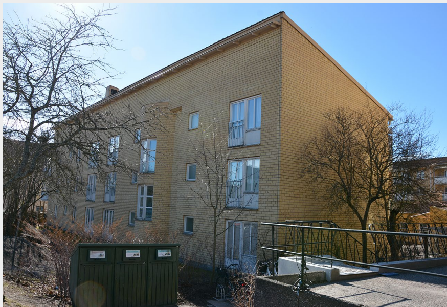
■ Flerbostadshus från 1985 med gult fasadtegel, pulpettak och rundat burspråk (Sandstenen 17). Foto: Vlm-vassb-0459.
