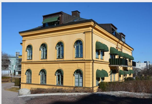
■ Före detta lasarettet, uppfört 1867. Rusticerad bottenvåning och klassiska arkitekturelement såsom slutsten ovan fönster, hörnkedjor, väggpelare och profilerad list vid takfot. Fasader i gul puts och grönmålade fönster med runda bågar. (Slottsträdgården 8). Foto: Vlm-vassb-0136.
