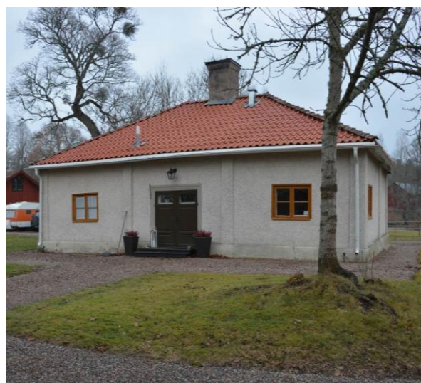
Östra flygeln. BildID: Vlm_kviEK-10.
