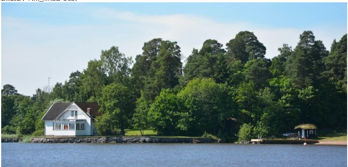
Före detta varmbadhuset på udden. BildID: Vlm_kviSB-455
