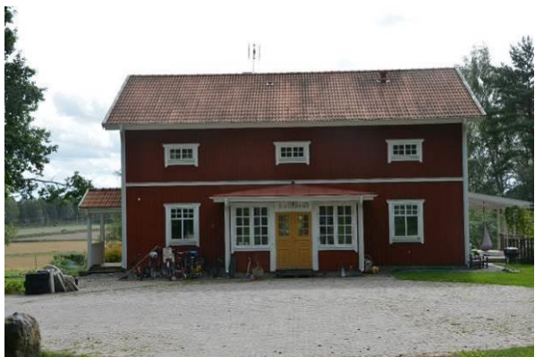
Renoverat bostadshus i äldre stil. BildID: Vlm_kviAF-1076.
